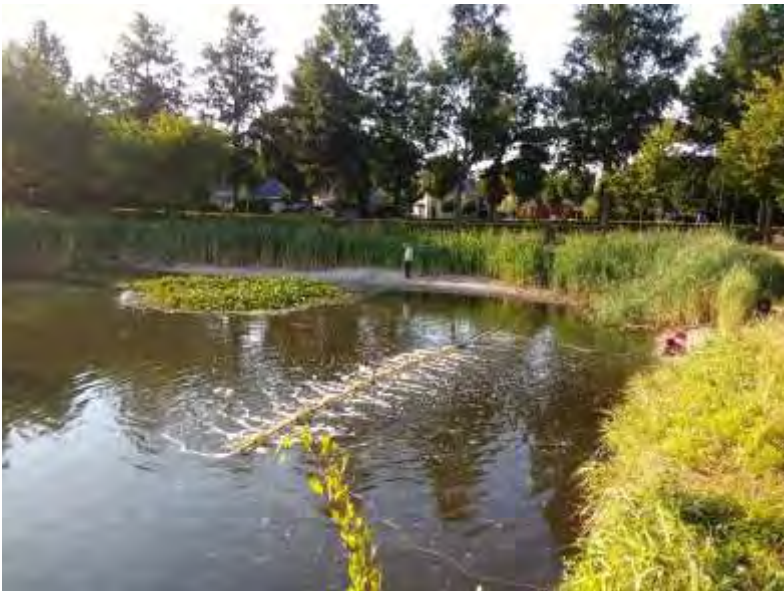
Afbeelding 2.2: Met zandzakken wordt door Waterschap Vallei en Veluwe water vastgehouden en turbulentie gecreëerd om water langer vast te houden en zuurstof in te brengen in de Staverendsebeek (foto: Robbin Buitink)
