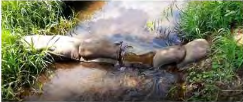
Afbeelding 2.2: Met zandzakken wordt door Waterschap Vallei en Veluwe water vastgehouden en turbulentie gecreëerd om water langer vast te houden en zuurstof in te brengen in de Staverendsebeek (foto: Robbin Buitink)
