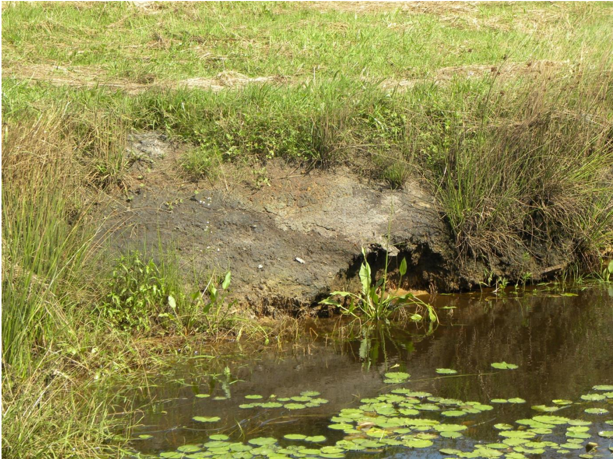
Afbeelding 5. Een jaar na herinrichting is in het Grootte Diep plaatselijk oevererosie zichtbaar.
