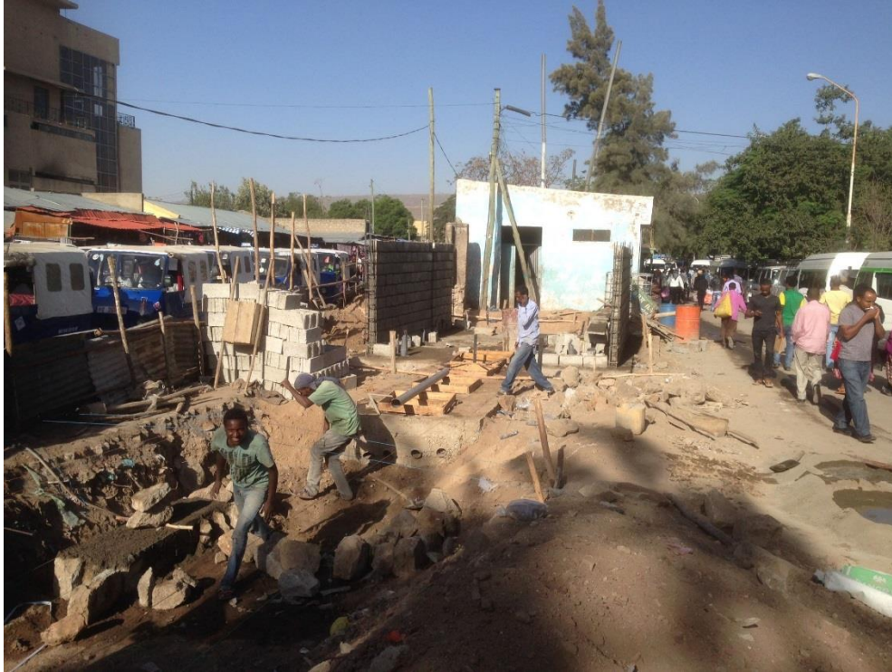
Afbeelding 5. Bouw van toilet en ABR bij het busstation
