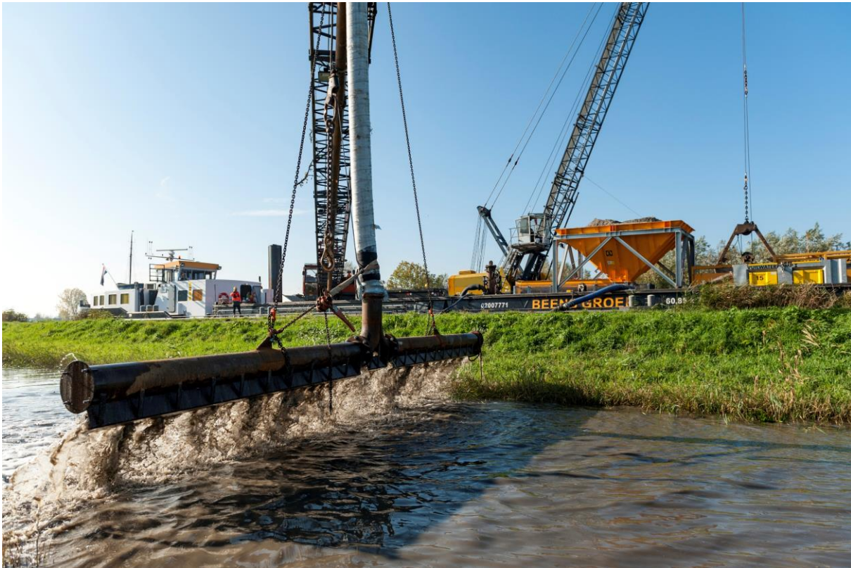
Afbeelding 2. Aanbrengen van een laagje zand
