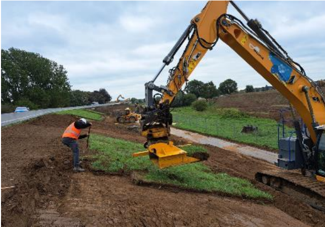
Afbeelding 1. Uitvoering zodetransplantaties (met door waterstof aangedreven materieel)
