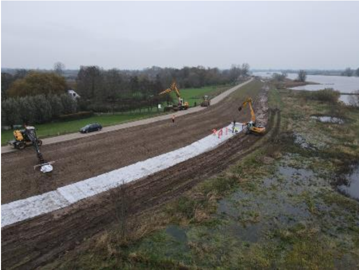
Afbeelding 2. Van eind november 2023 tot begin mei 2024 is het onderste deel van de dijk ingepakt geweest
