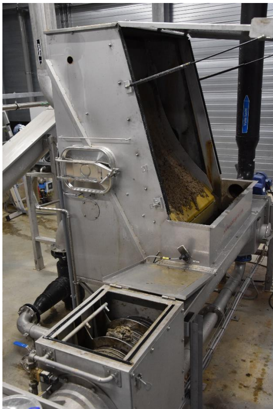
Afbeelding 5. Foto van zeefbocht met ontwateringspers op rwzi Leidsche Rijn
