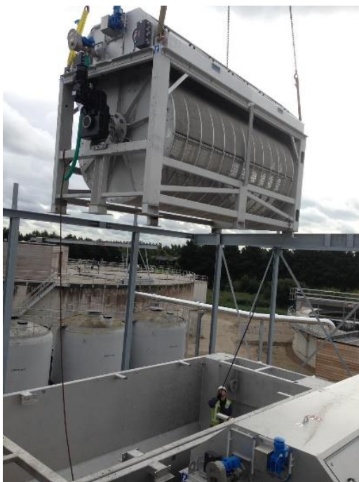
Afbeelding 3. Links: positionering van een trommelzeef op rwzi Leidsche Rijn. Rechts: binnenaanzicht van de korf van een trommelzeef, met bovenin de opvanggoot
