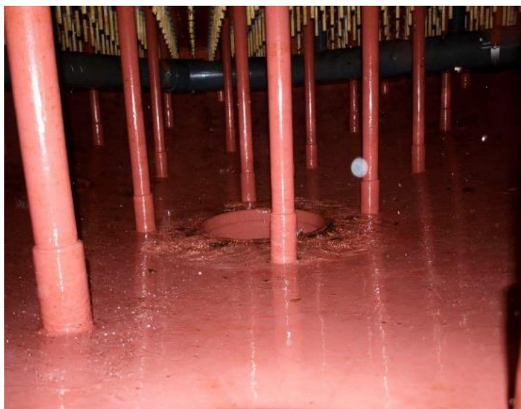
Afbeelding 4. Filtraatruimte onder de BODAC-filters: geen biofouling
