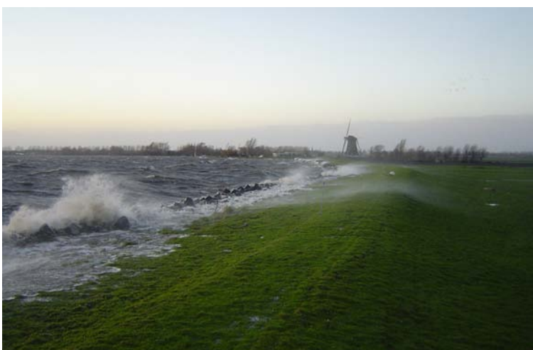
Afbeelding 2. De kades zijn verhoogd en verbreed om ze te stabiliseren en beter bestand te maken tegen golfploop, zoals hier aan de oostzijde van het Braassemermeer
