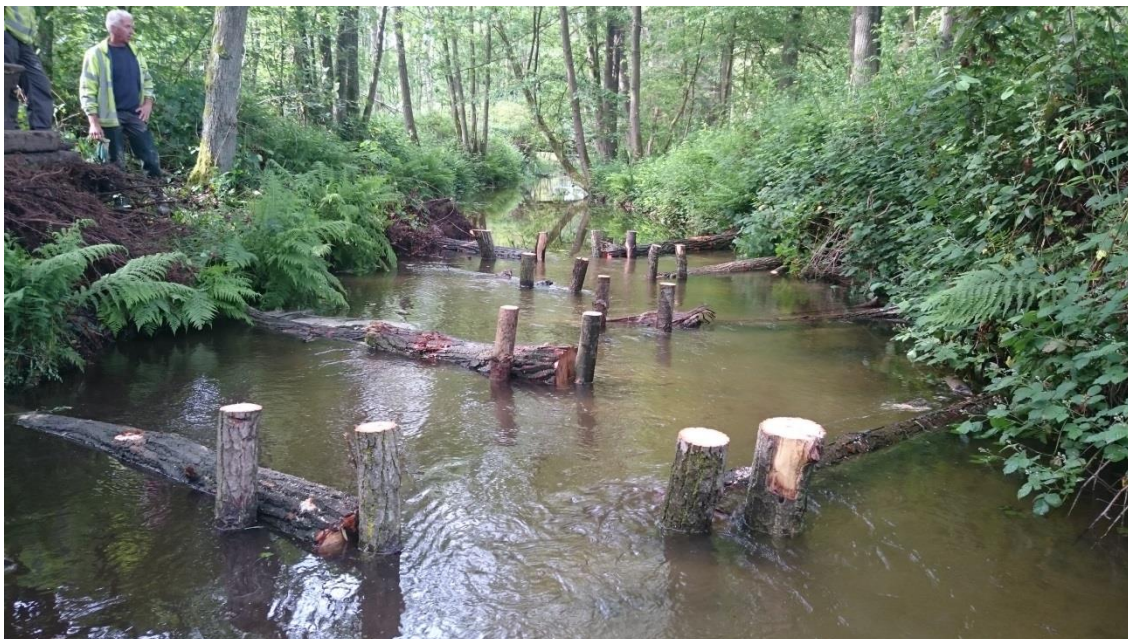
Afbeelding 3. Bij beekloop 't Schut zijn obstakels (hout) ingebracht voor het creëren van de natuurlijke processen stroming en substraatvorming. Dit valt onder het concept 'Building with Nature' [5].
